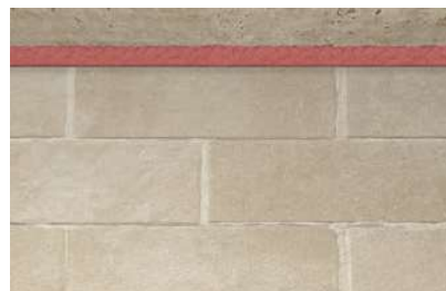
Aplicación en juntas de construcción
