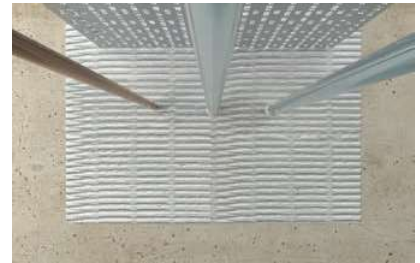
Paso de instalaciones mixtas a través de la pared
