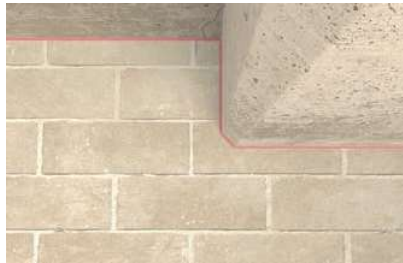
Aplicación en juntas de construcción
