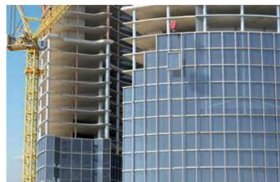
Muro cortina unificado
