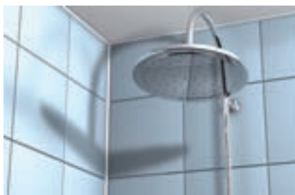
Juntas en baños
