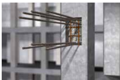
Hierros de construcción
